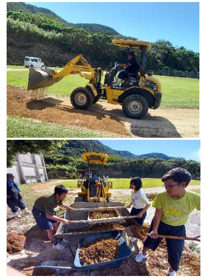
重機による整地作業(上) 土をふるう子供たち(下)
